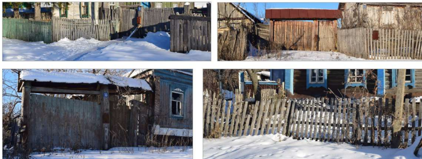
Существующий состояние ограждений, калиток, ворот
