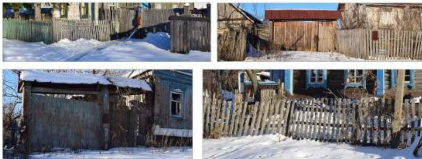
Существующий состояние ограждений, калиток, ворот
